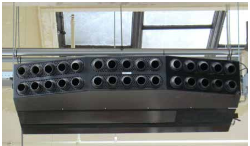
Elk plenum is uitgerust met twee rijen nozzles
