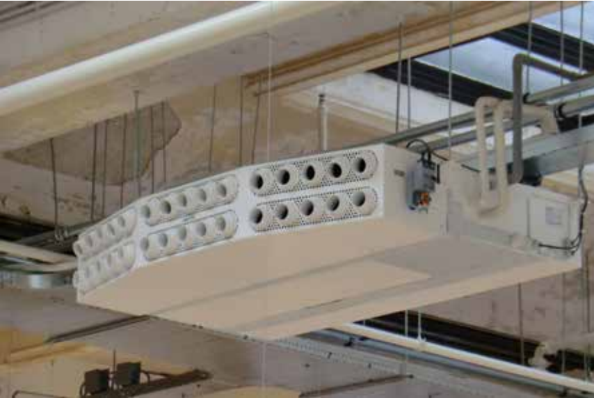
Gemotoriseerde regelbare compartimenten in de plena zorgen bij elke inblaasstemperatuur voor een optimaal luchtpatroon
