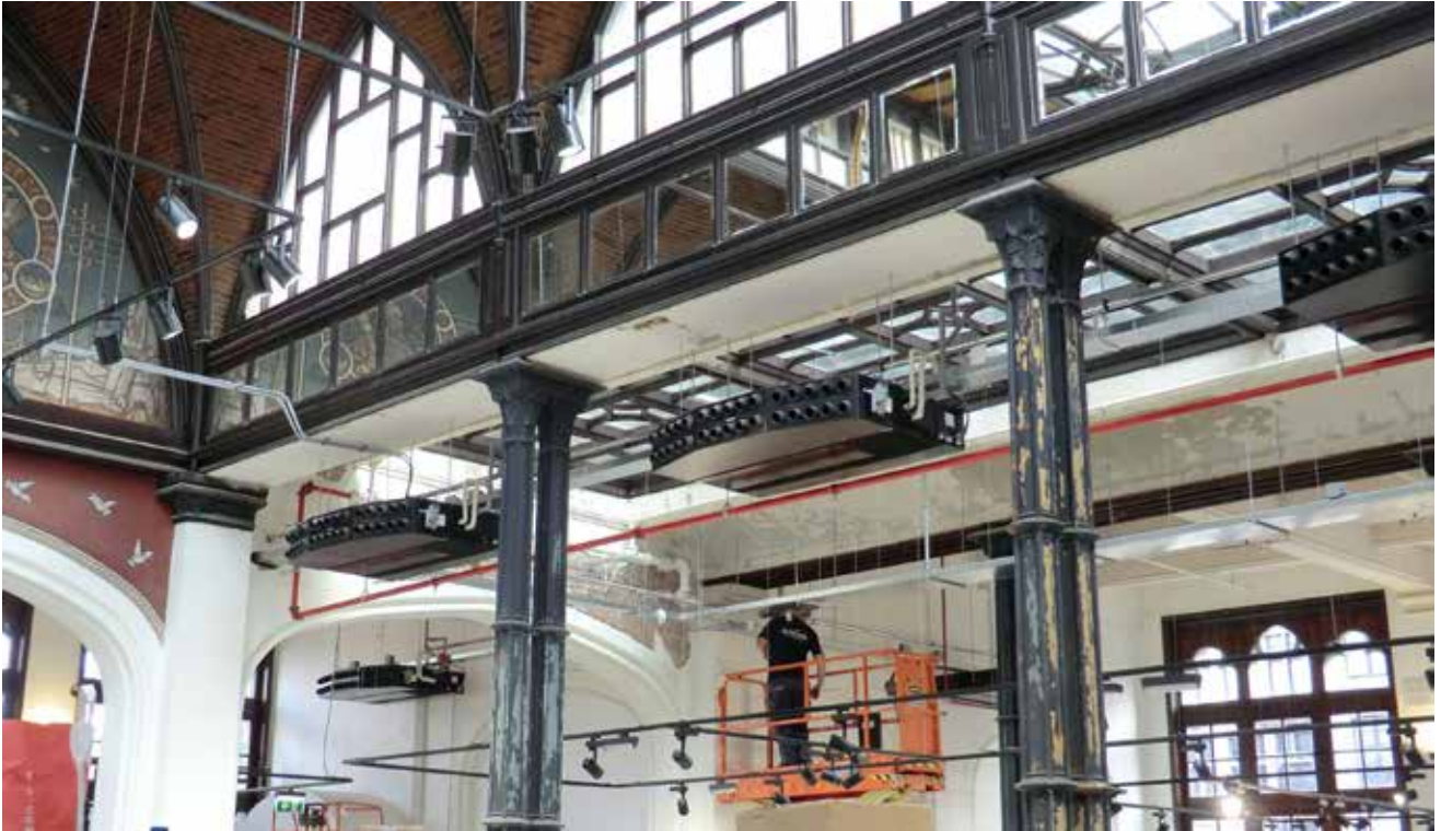
De nozzles zijn standaard in een witte of zwarte uitvoering verkrijgbaar, de plena en de luchtroosters worden gepoedercoat in een RAL-kleur naar wens
