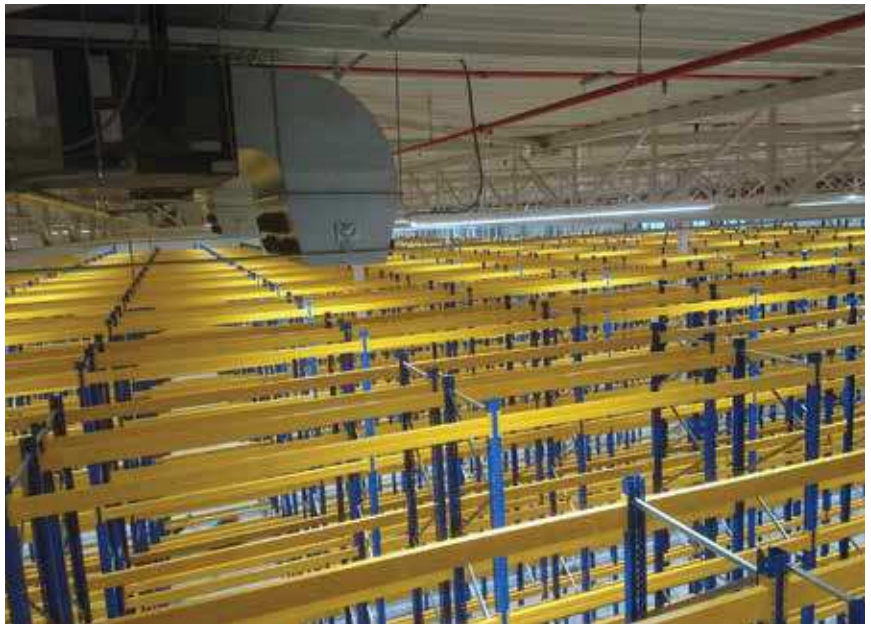
In tegenstelling tot de SAC-plena hebben de SAC-R plena een ronde uitvoering (Foto's Smitsair Jetsystemen B.V.)
