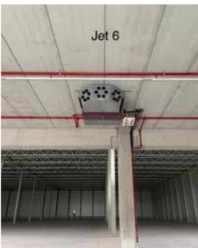
De SAC-plena hebben een grote worp bij relatief lage druk, zijn toepasbaar op vrijwel elk type airco-unit. Ook de luchtrichting is goed instelbaar
